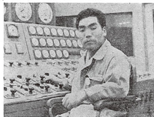
(中央操作室ボイラー制御盤にて)
