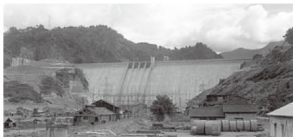
田子倉発電所
